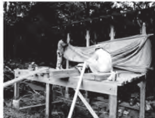
ウッドデッキをつくる
