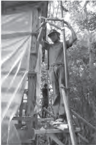
壁をつくるための足場を組む
