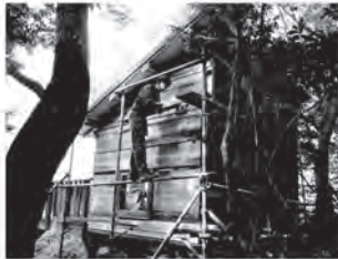
扉、窓の製作、縦に内壁を打つ
