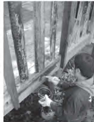
手すりをつくり防腐剤を塗る
