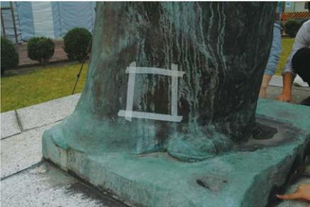
図6 《バルザック》正面下中央部の洗浄パッチ
