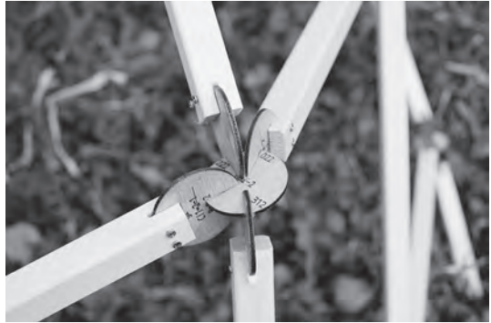
図 37 縦横の角材が組まれた接合部
