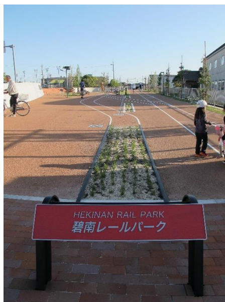
図 77 ケース 3.完成した公園の様子
