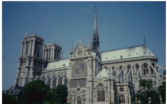
Fig.14 飛梁（ノートルダム大聖堂） パリ 筆者撮影 1989年
