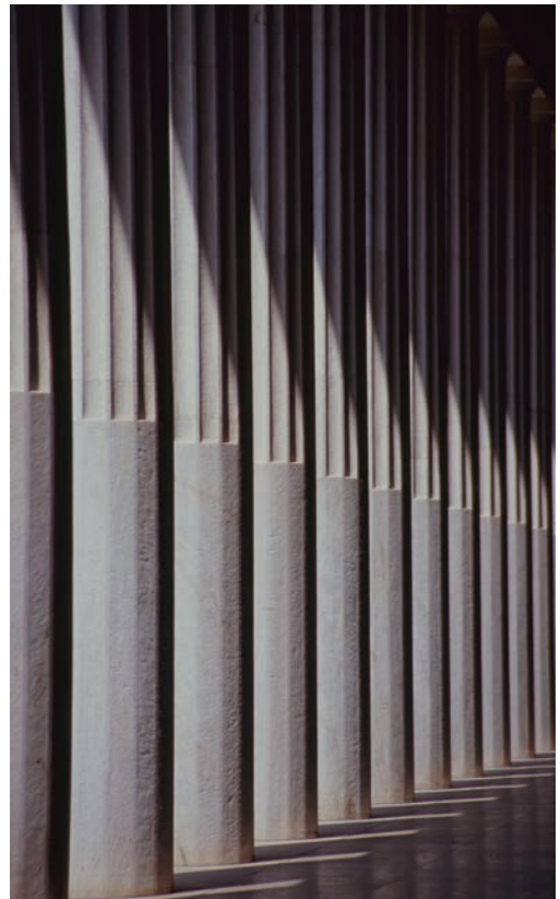
Fig.9 フルーティング（アッタロスの柱廊） アテネ 作者撮影 2003年9月
